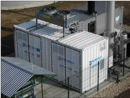
Biogas opgraderingsenhed i ISO stål container
