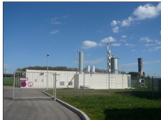
Oversigtsbillede over biogas opgraderingsanlægget bestilt i 2010
