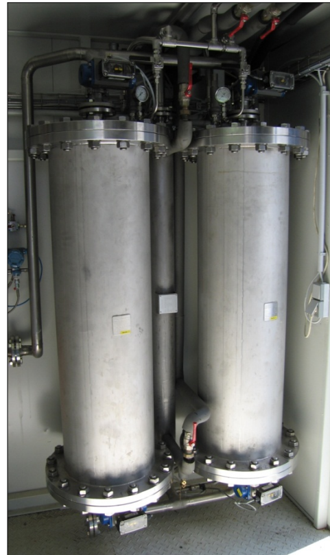
Jernoxid opsuger for den endelige biogas afsvovling
