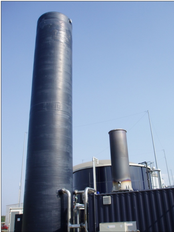
Biologisk skrubber for rå biogas afsvovling
