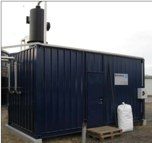
Visning udefra af den kemiske-oxidative skrubber til rå biogas afsvovling
