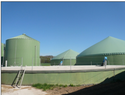
Tre udviklingsfaser: (i) Bagerst til venstre, Lipp GmbH, (ii) forrest, selvbygget tank, (iii) Bagerst midtfor og til højre, Novatech GmbH
